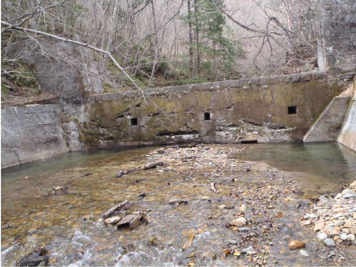
堰堤の左右両端には、小さなプールができていた。
