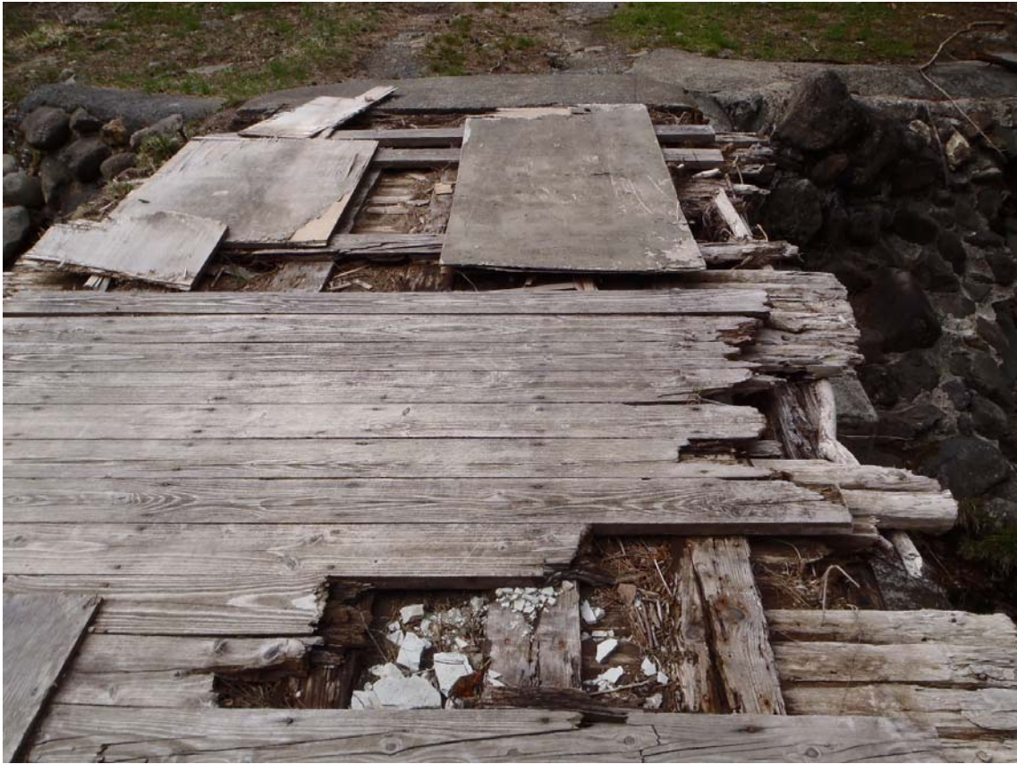
沢①の橋 車での通行は不可能
