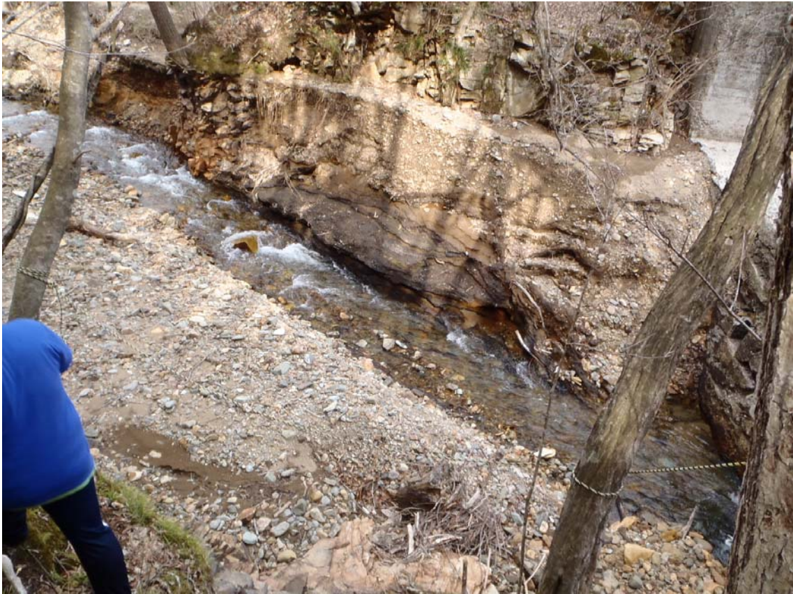
堰堤上部は崩落の可能性あり。
